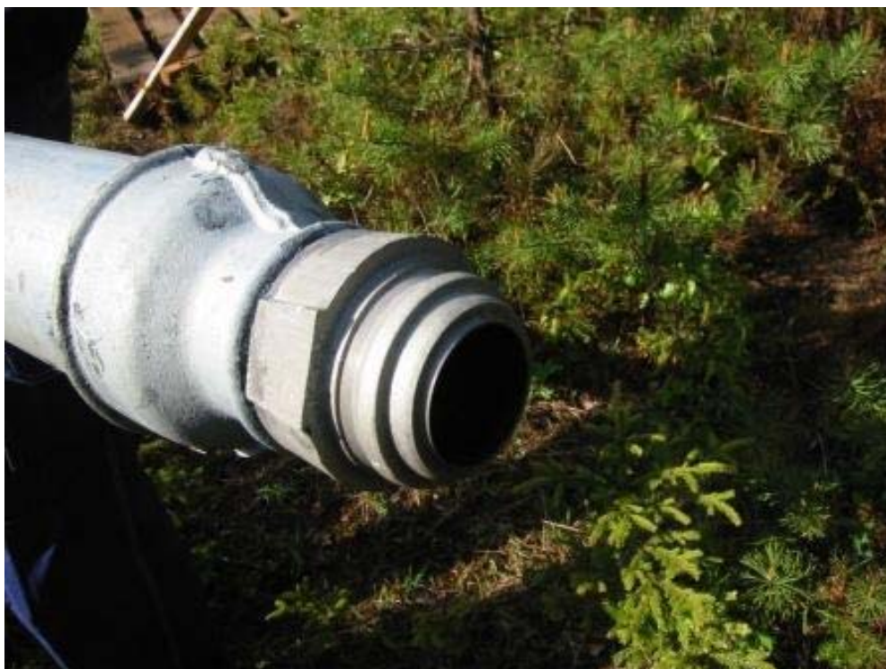
Foto 13 P/V-ventil på avluftsledning efter försöken. Regnskyddet blåste av vid antändningsförsöket.
