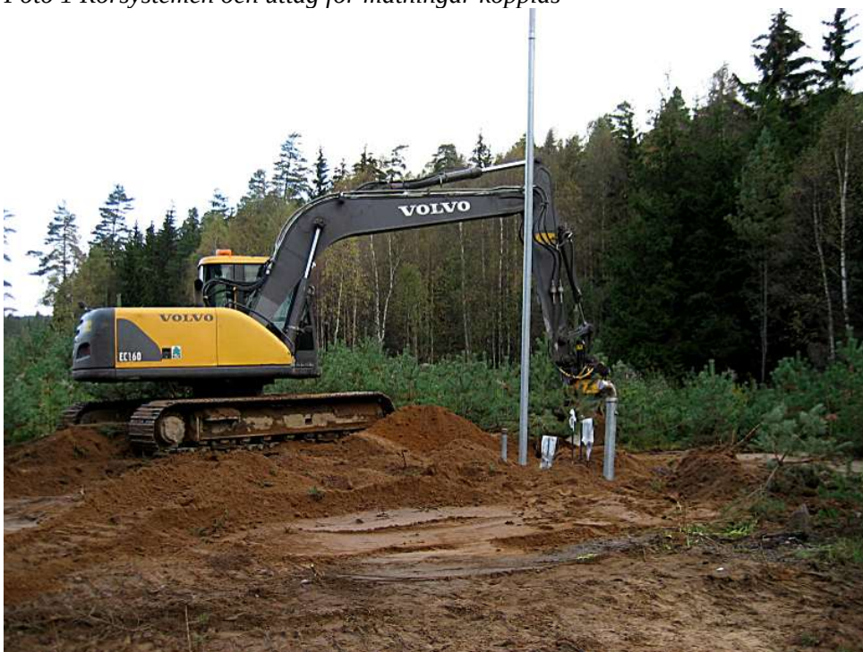
Foto 2 Återfyllnaden runt cisternen nästan klar
