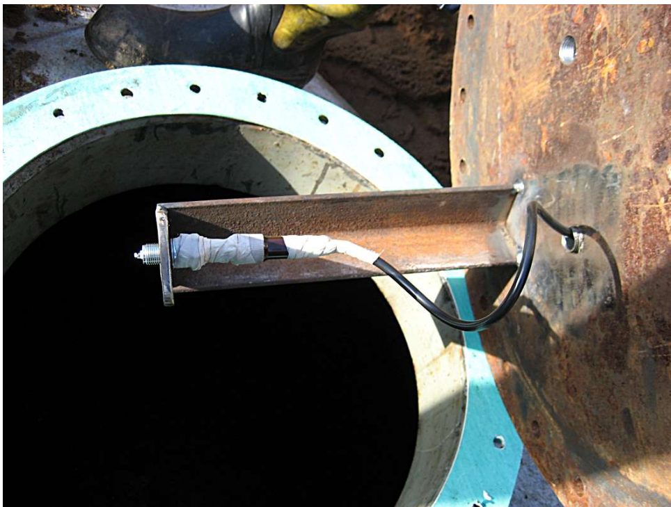
Foto 5 Tändstift inne i cistern
